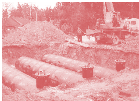
Рис. 4.6. Монтаж резервуаров подземного размещения
