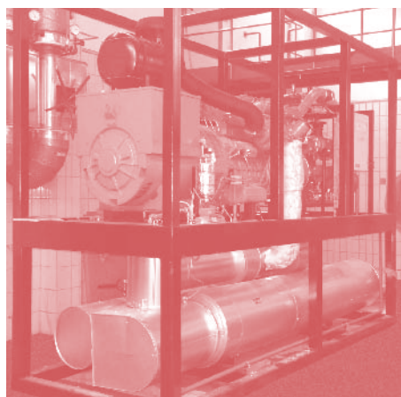
Рис. 9.15. Внутреннее устройство когенерационной газовой установки
