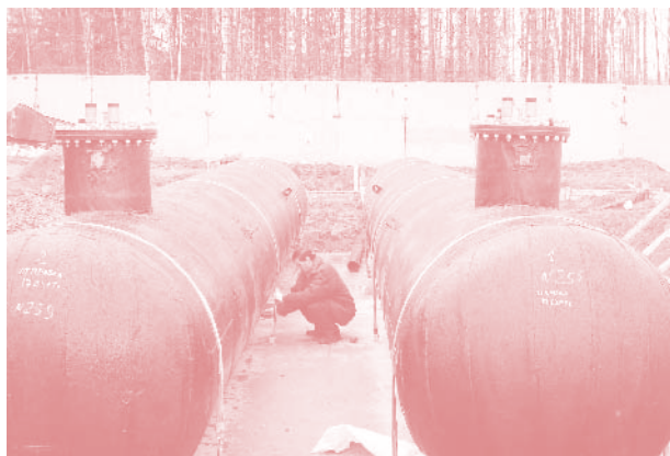
Рис. 4.10. Фиксация резервуаров подземного размещения на фундаменте производится металлопластиковыми стропами
