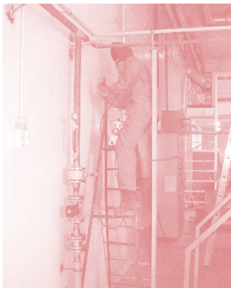
Рис. 5.15. Монтаж внутрицехового газопровода
