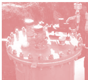
Рис. 4.11. Горловина резервуара СУГ объемом 20 м 3 подземного размещения (ООО «Фасхиммаш») с арматурой
